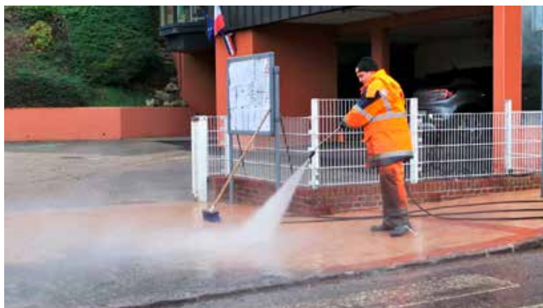
► Nettoyage des trottoirs au karcher et remise en place de sable dans les joints des pavés autobloquants place de la mairie (ci-dessous) : ce n'était pas du luxe !
