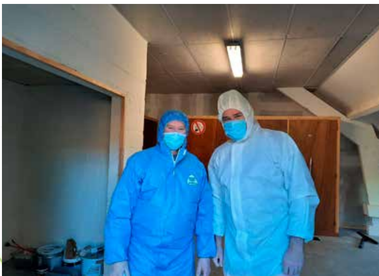
► Travaux de peinture : le domaine de prédilection de Mickaël et Pascal !
