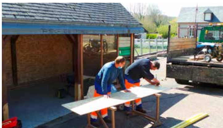
► Réfection de l'abribus du bourg, isolation
