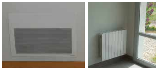
L'entreprise Delaune a procédé aux retraits des convecteurs et a procédé à la mise en place des nouveaux.
