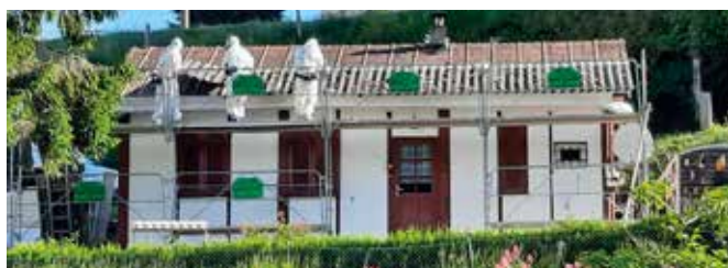
Opération de désamiantage avant réfection
