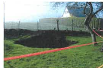
Mouvement de terrain (falaises et cavités souterraines)
