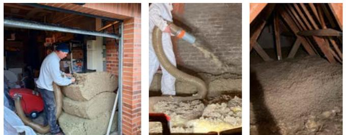
▲ Préparation de la machine, opération en cours, jauge pour mesurer l'épaisseur nécessaire
