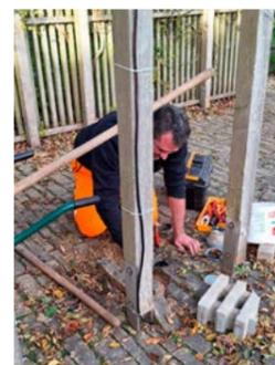
Reprise de l'éclairage de l'allée entre le parking et la salle Georges Braque. L'éclairage au sol étant souvent défectueux et hors service à cause d'infiltrations d'eau dans les spots, les agents de l'équipe technique ont installé des éclairages sur les palissades en bois qui longent l'allée menant à la maison commune.
