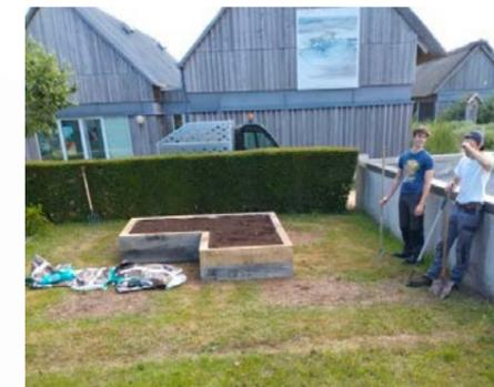
▲ Réalisation de l'assemblage du bois, puis pose du textile ▲
