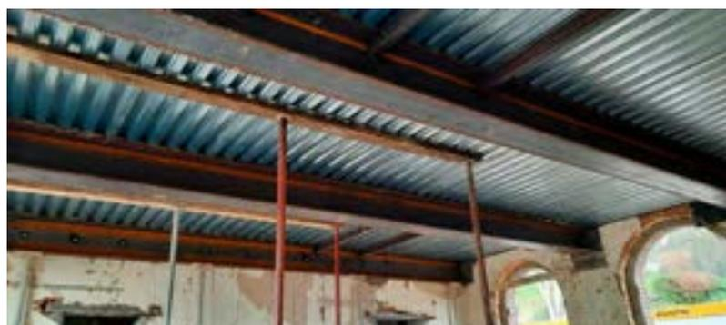
*Opération délicate, renforcement et consolidation des planchers*
