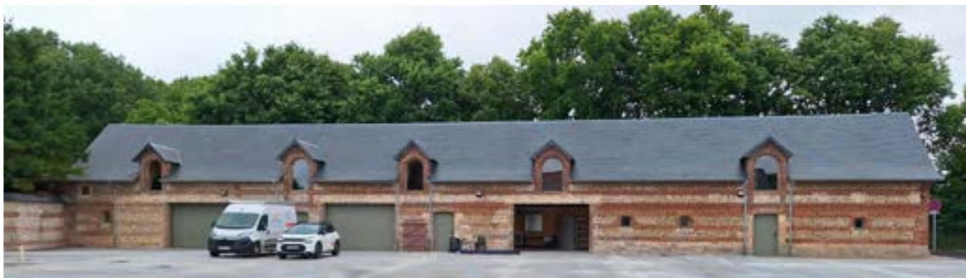
Une belle rénovation pour un bâtiment qui le méritait
