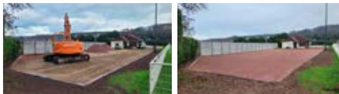
Mise en œuvre des traverses en bois, du tout-venant avant étalage du sable rouge, un beau résultat !
