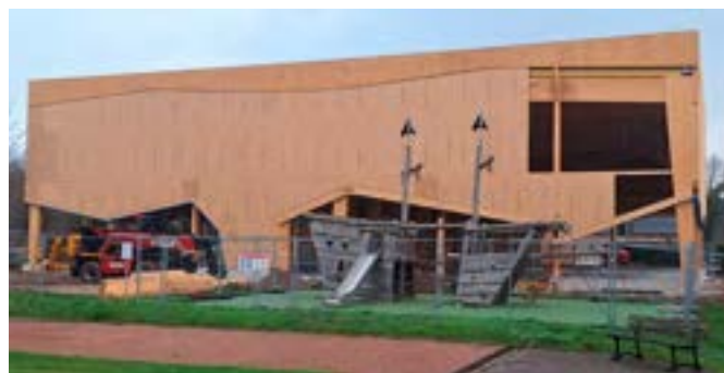
Charpente, toiture, dalle et murs réalisés
