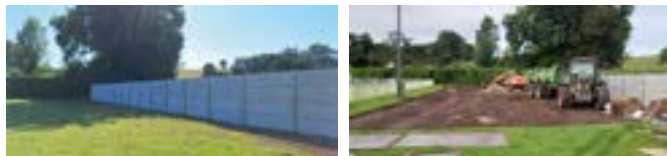
Pose de palissades après arrachage de la haie et terrassements
